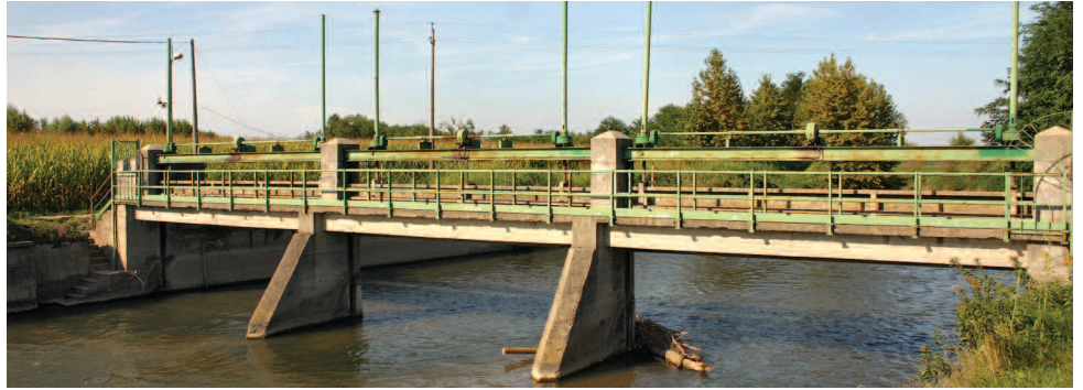
Sbarramento sul tratto di pianura del fiume
